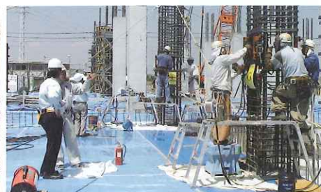
現地審査状況
