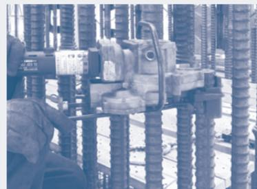
鉄筋冷間直角切断機による切断
