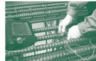
溶接継手部の超音波探傷検査
