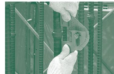
ガス圧接継手部の外観検査
