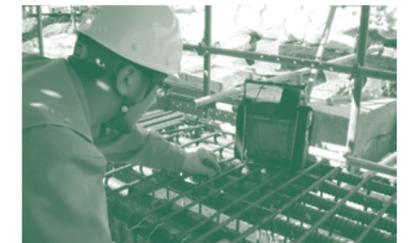
機械式継手部の超音波測定検査
