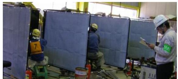
写真 5 鉄筋溶接技量検定試験の様子
