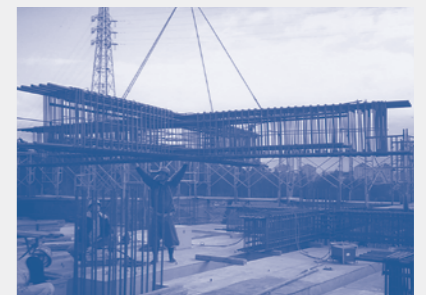
先組み鉄筋工法の例
